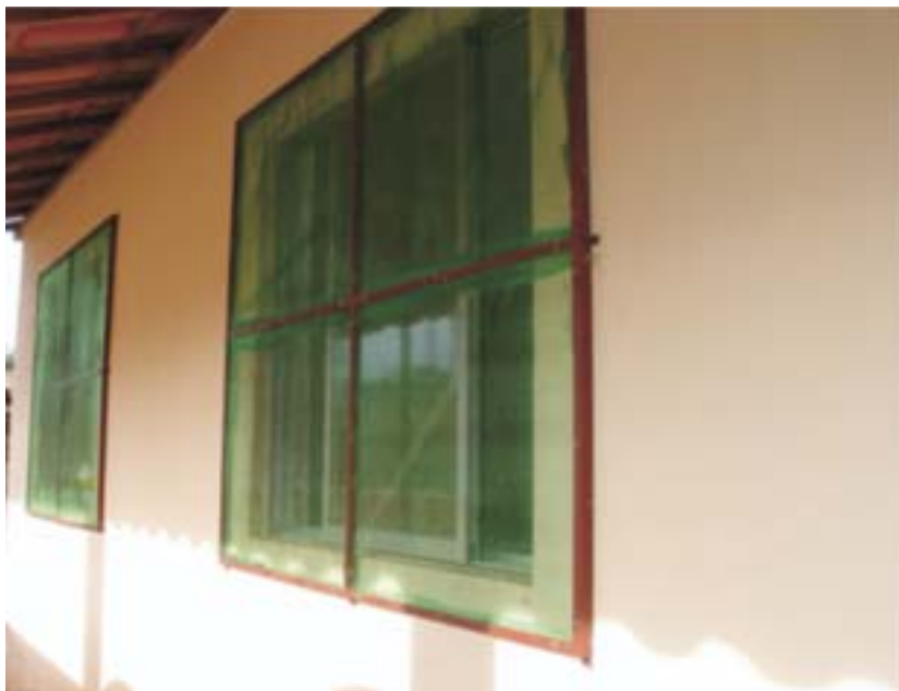
Janelas da queijaria cercadas de tela
