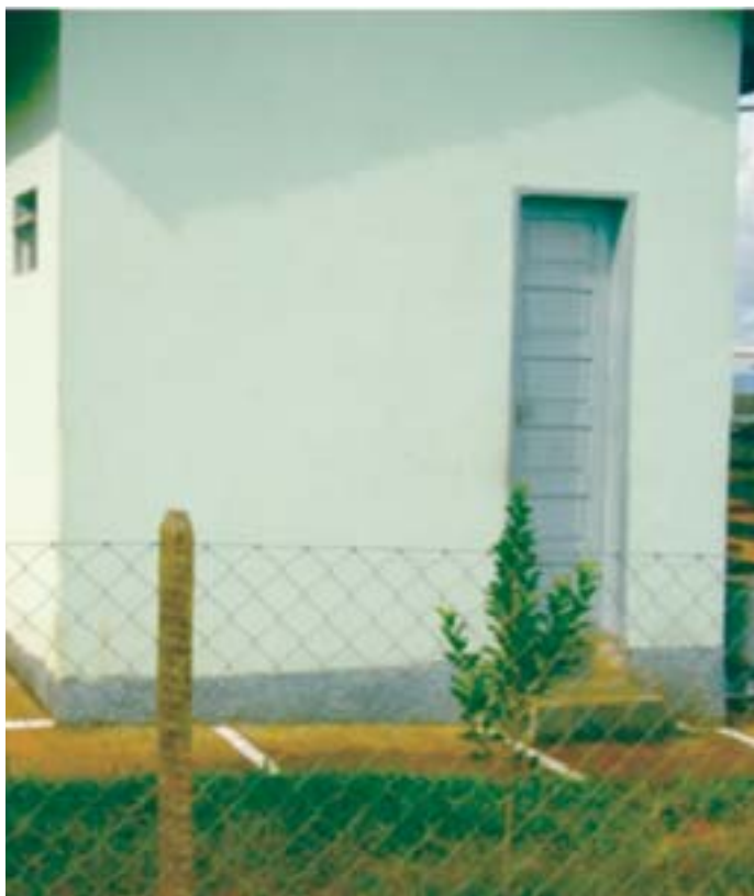
Instalação sanitária da queijaria
