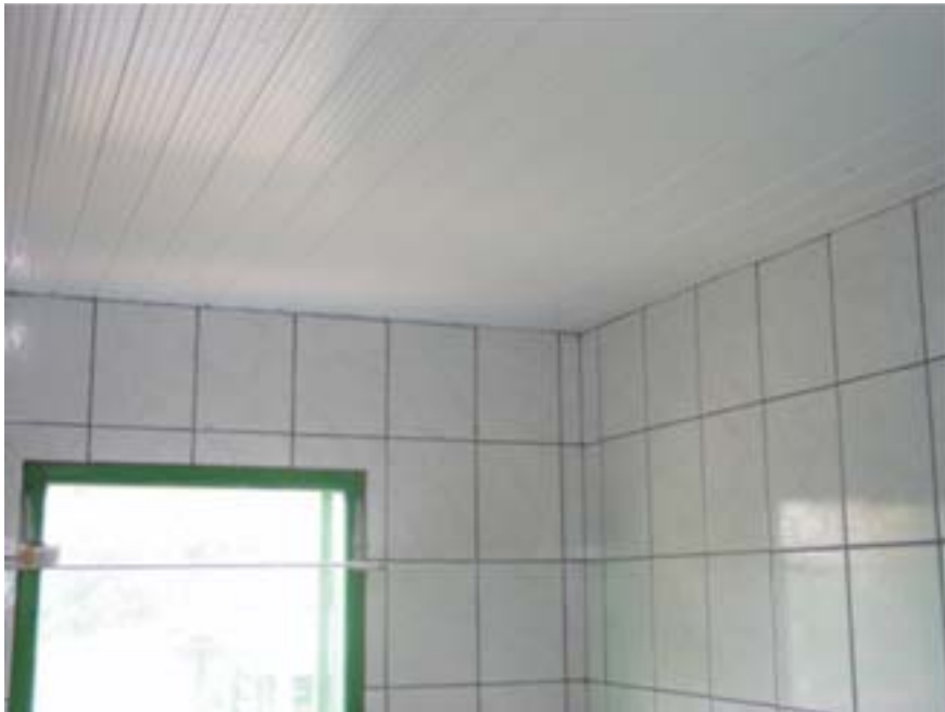
Teto de PVC e paredes de azulejo: facilidade na limpeza
