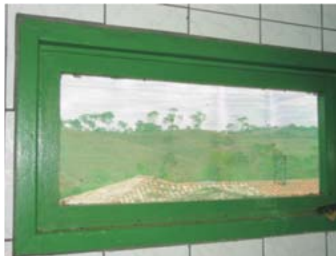
Abertura lateral na queijaria para uma ventilação adequada
