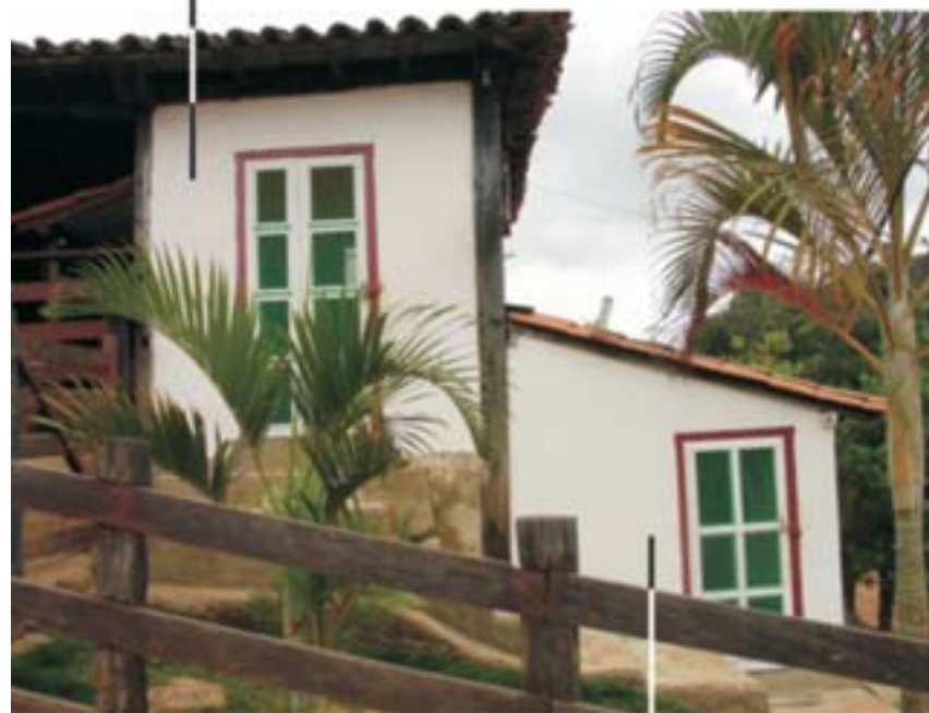
Sala de armazenamento de insumos, materiais de limpeza, entre outros
