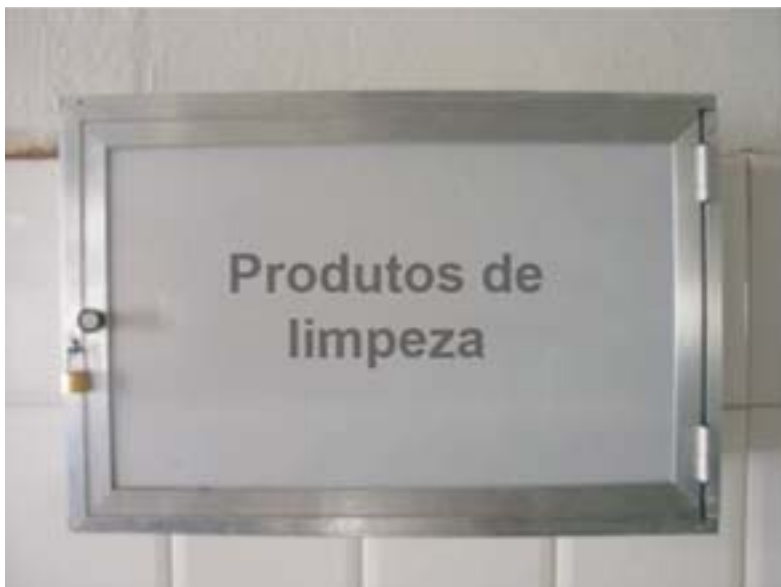
Armário para guardar materiais de limpeza e desinfecção
