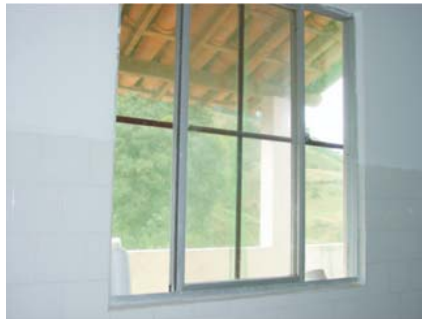
Janela de vidro com base de alumínio e com tela protetora externa
