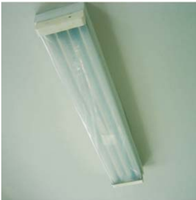
Lâmpadas com proteção (transparente): segurança no trabalho
