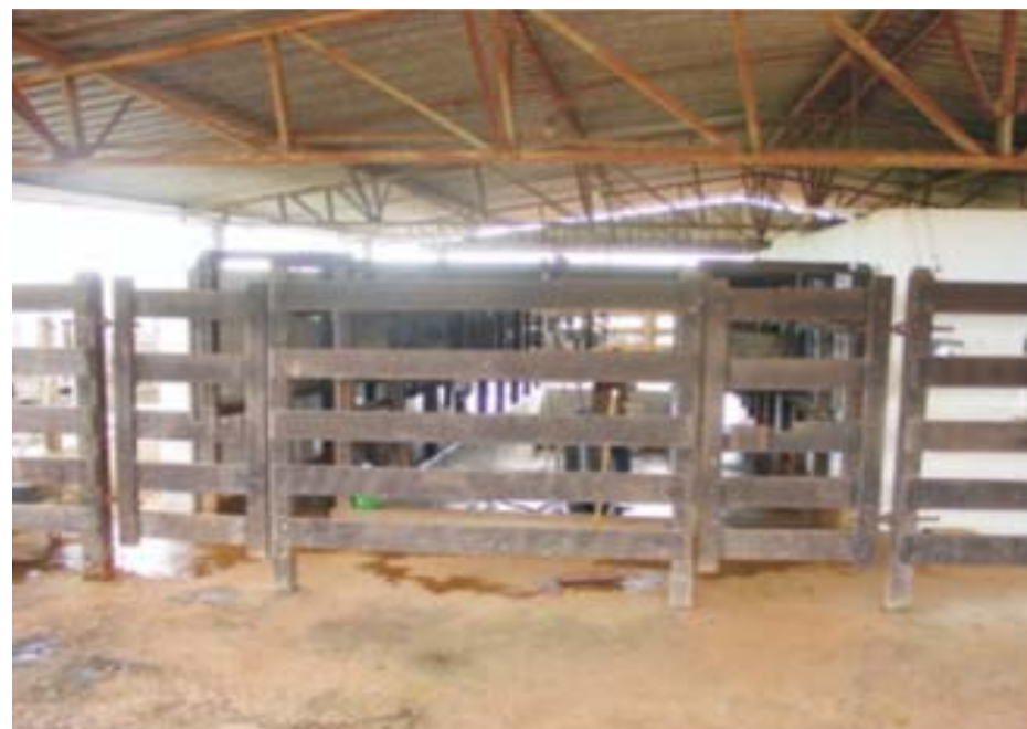
Curral concretado, cercado com régua de madeira
