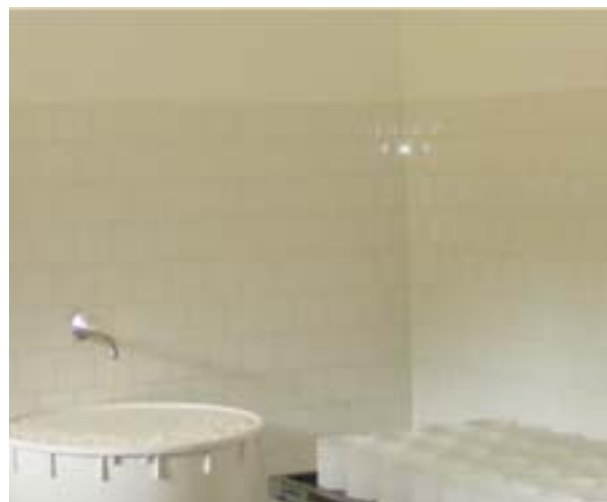
Paredes da queijaria com 2 metros de impermeabilização
