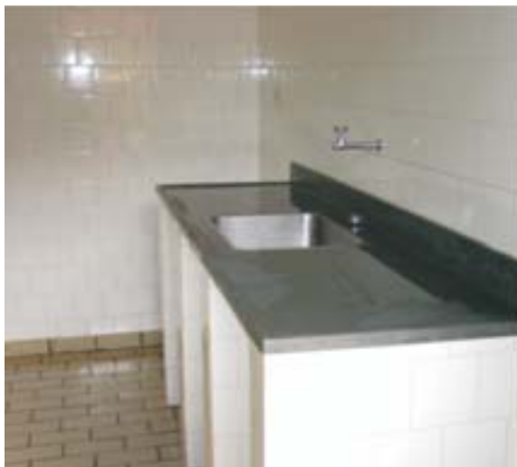
Pia de aço inox com torneira de água corrente para higienização de utensílios
